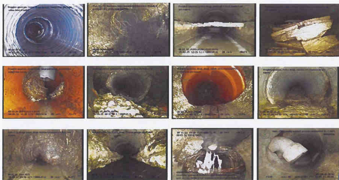
Slika 6: Prikaz posameznih primerov poškodb in posebnosti kanalizacijskega omrežja, posnetih pri pregledu s TV-kamero
